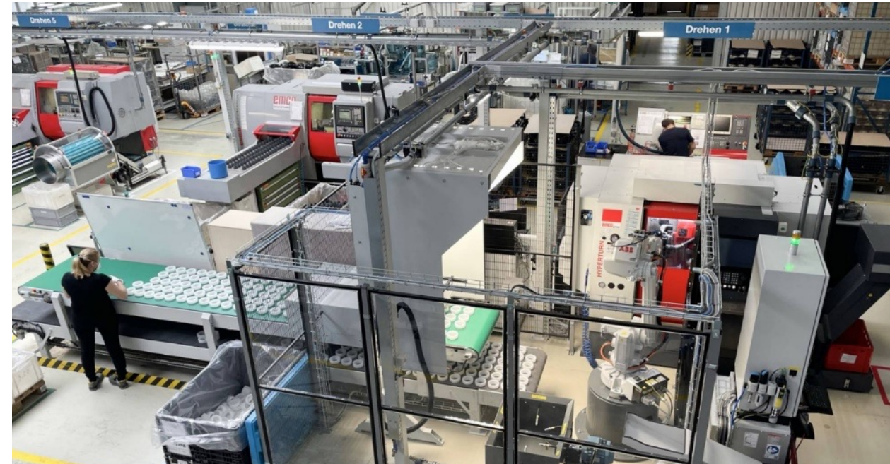
Die Automatisierungszelle bei Praher besteht aus einem Dreh-Fräszentrum Hyperturn 45 inklusive Späneabsaugung von Emco sowie einer ABB-Roboterzelle Flexloader™ FP600 mit Entgratstation und Ablaseinheit.
